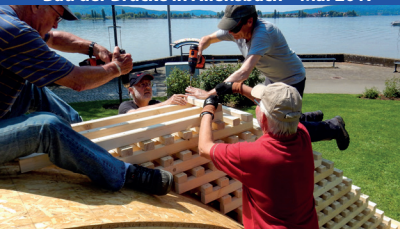
Bau der Brücke in Allensbach – Mai 2017
