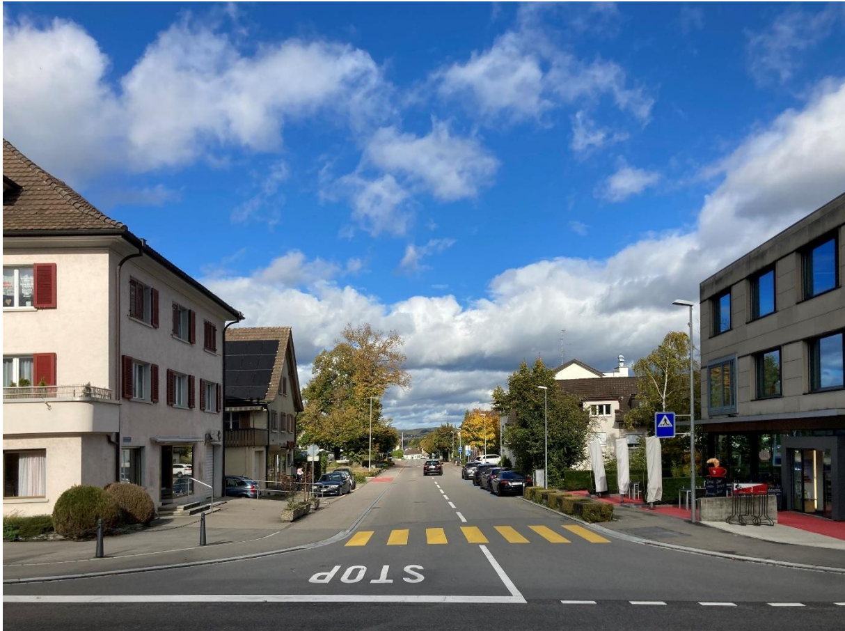
Abb. 1: Bahnhofstrasse Süd, Blickrichtung nach Norden
