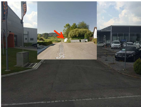
Standort Trafostation Schützenstrasse
