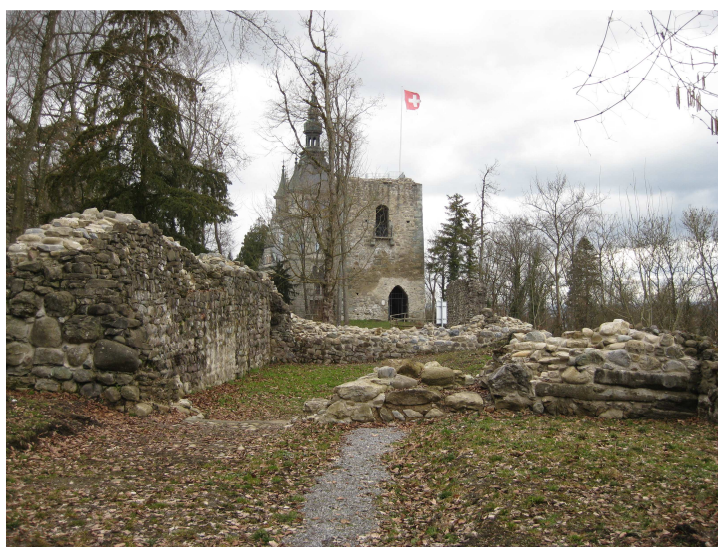
Sanierung Mauerwerke um die Ruine Castell
