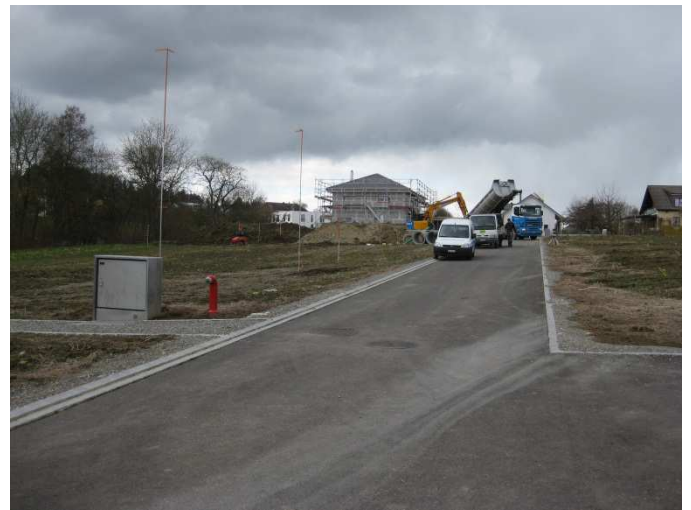
Erschliessung im Rüssel
